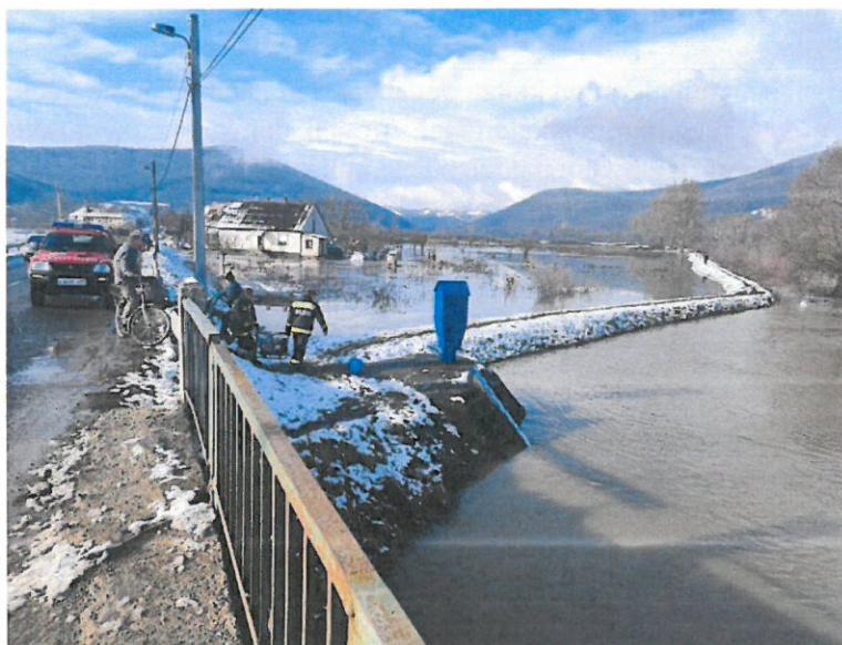
Védekezési munkálatok a Szalonnai hídnál
